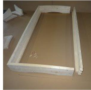
**ACHTUNG:** Ist in Ihrem Bett eine Mittelleiste vorgesehen, **MUSS** diese vor dem zusammenbau des Bettkastens in die Querteile eingebaut werden.
