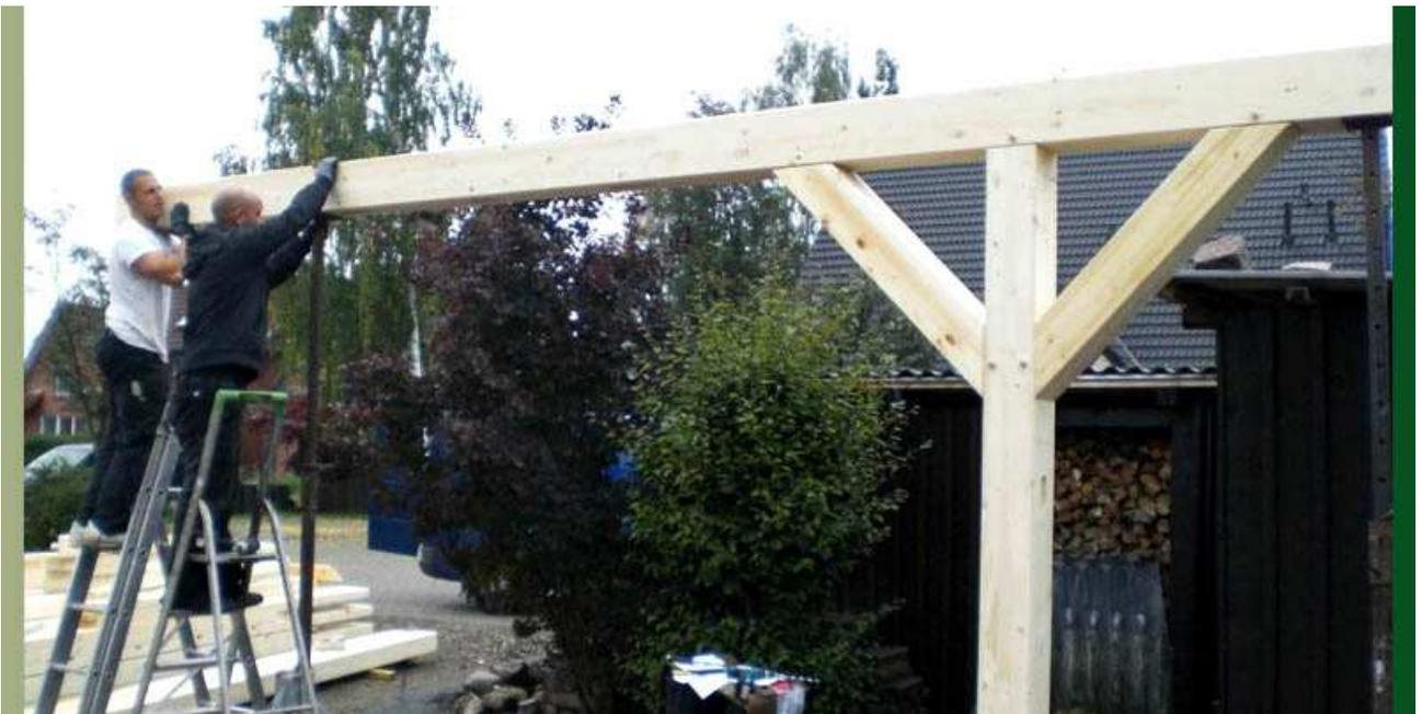
Sollten Sie mehrere Pfosten benötigen, werden diese im selben Prinzip angebracht. Je nachdem für welche Carportbreite bzw. Länge Sie sich entschieden haben.
