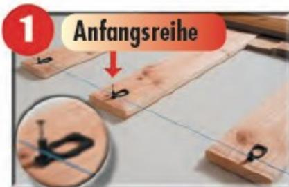
Die Anfangsreihe (und später auch die letzte Diele) wird mit einem halben Abstandshalter begonnen bzw. beendet. Die Abstandshalter haben eine Sollbruchstelle, wo sie per Hand gebrochen werden können. Für ein optimales Ergebnis am besten die erste Reihe mit einer Schnur ausrichten.
