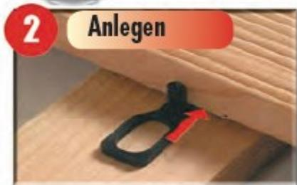
Alle folgenden Abstandshalter werden unter die Dielen geschoben und von oben so verschraubt, dass - sh. Bild 3
