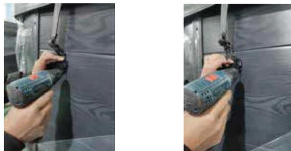
Schritt 4 - Benutzen Sie einen Schraubenzieher, um die 3 Schrauben fertig einzuschrauben. (Wiederholen Sie diesen Vorgang für die anderen 3 Ecken.)
